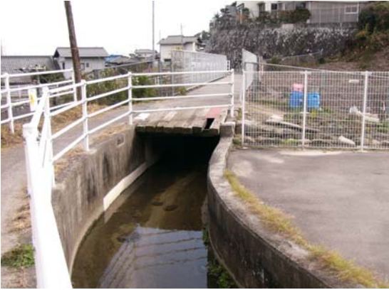
跨線橋へ向かって流れていく水路の水
