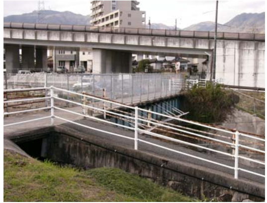
JR山陽本線の跨線橋の下に鉄製の箱型枠があり水路としている
